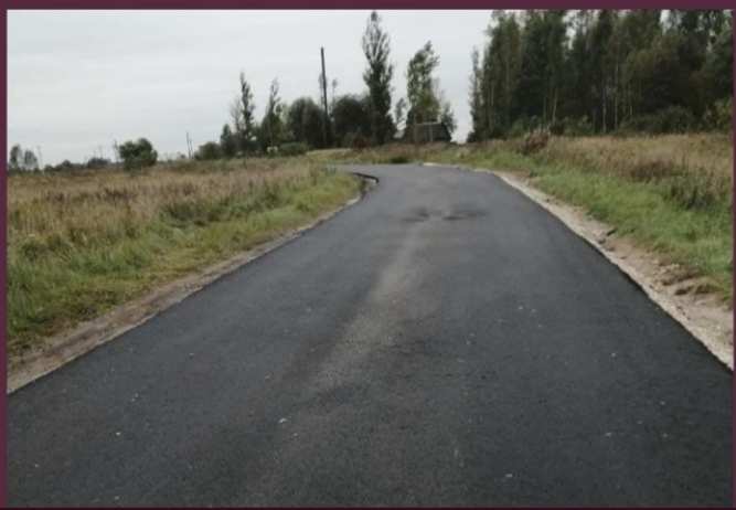
Ремонт автодорог с. Волое, д. Выползово д. Буда
